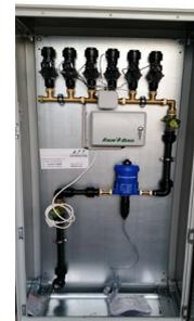
Anschluss an das Trinkwassernetz nur über einen Systemtrenner zulässig.
