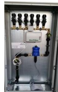
Anschluss an das Trinkwassernetz nur über einen Systemtrenner zulässig.
